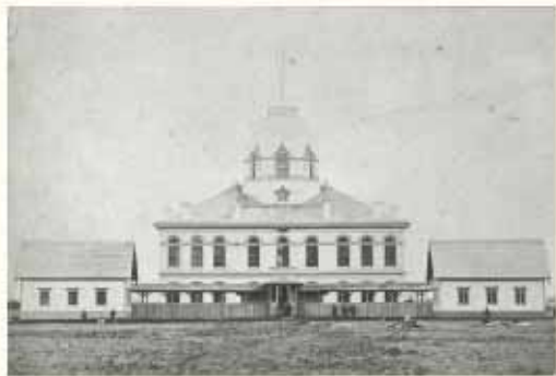
▲明治6(1873)年に完成した開拓使札幌本庁舎 (北海道大学附属図書館所蔵)
