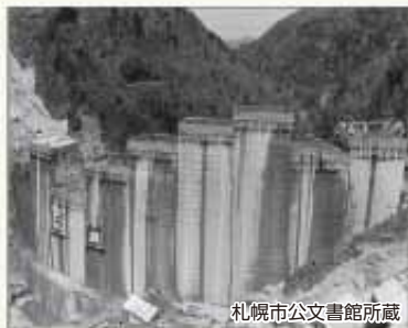
▲アーチ型の構造をした建設工事中の豊平峡ダム
