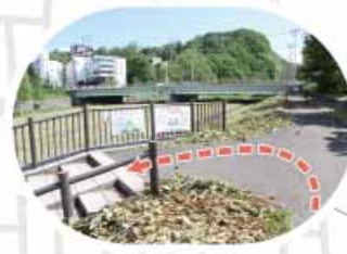
山の手橋の下を通る (橋の手前にスロープがある)
