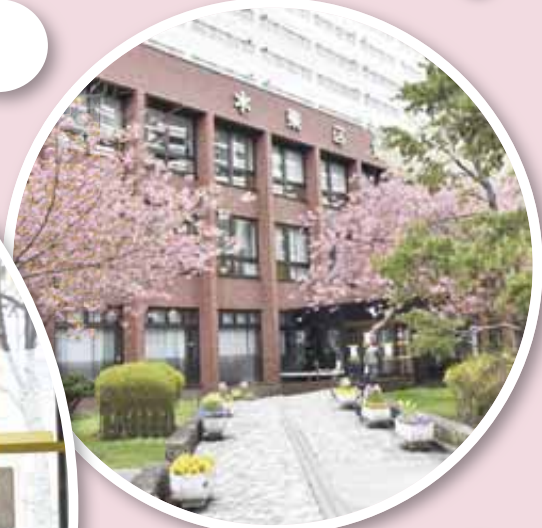
東区役所正面玄関
