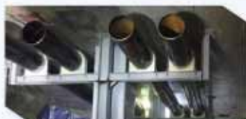
◀▲創世スクエア内の市民交流プラザ(写真左)と周辺地区に温水などを送る熱導管(写真上)
