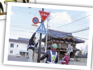
▲標識補修ボランティアの様子
