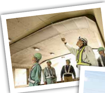
◀土木部との防災訓練でトンネルを点検する様子
