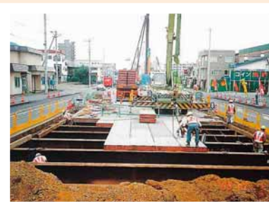
▲路面覆工板設置作業
