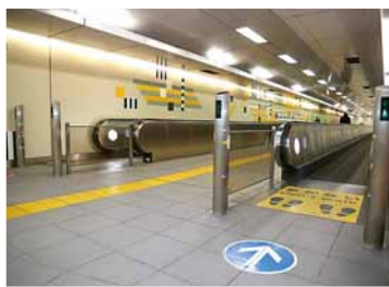
▲5番出口付近にある「動く歩道」
