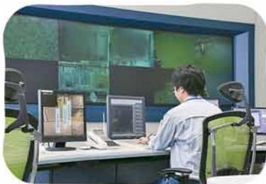
浄水場の全ての情報が集まる中央管理室。24時間体制で水質データの監視や浄水場内の各設備の制御をしています。
