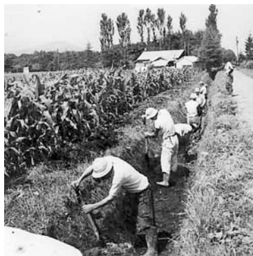
昭和17年、平岡4条2丁目付近。みんなで協力して排水溝を掘り、畑の土地改良に努めました。
