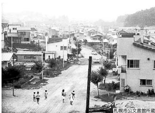
昭和44年の清田7条3丁目付近。 煙は見られず、住宅が立ち並んでいます。
