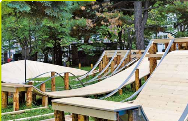
裏庭に建設中のコロガル公園。出来上がるまであと少し！▶
