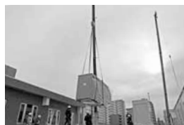
安全に注意して、無線で確認しながら自家発電機を設置！
