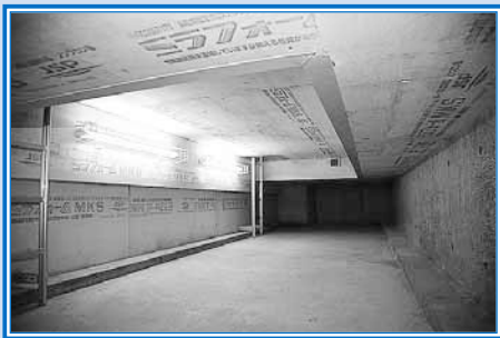
◀集会室のステージ下に設置された備蓄庫
