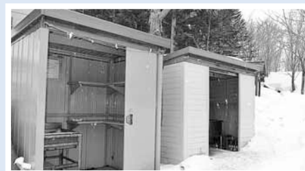
▲プレハブの水くみ場のホースからは豊富な水が湧き出ています
