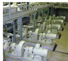
手稲区の曙ポンプ場のポンプ設備。夜間運転により、日中の消費電力を削減する。
