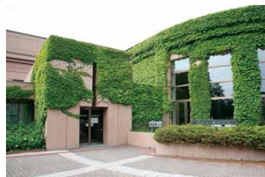
▲壁面緑化が涼しげな「ツインキャップ」
