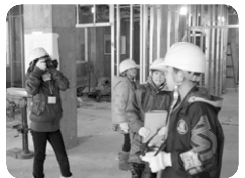
建設中の「ちあふる」内部も取材しました
