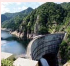
道内最大のアーチ式コンクリートダム
