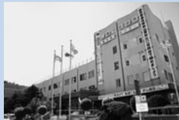
▲耐震工事も終了しました
