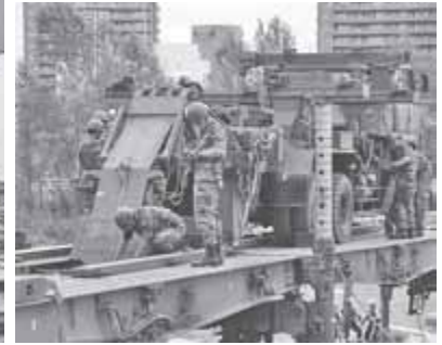
▶テキパキ組まれる仮設橋
