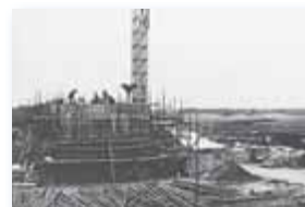
▲団地の建設工事
