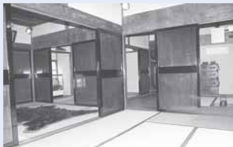
▲旧棟部（座敷）。中廊下を経て4つの部屋がある。
