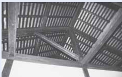
▲旧棟部の屋根の荷重を支える洋風小屋組。
