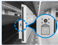
ホーム柵非常解錠ボタン
