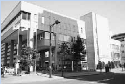
▲西区役所庁舎
