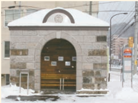
▶軟石表面の斜めの筋は手掘り時代に産出された証し
