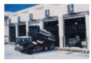
ごみ焼却場などの熱を利用し、雪を溶かす融雪槽。平成17年に11カ所目設置された。融雪槽では設置場所周辺の雪が処理されている。
