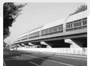
積雪対策と騒音防止対策を兼ねたアルミ合金製のシェルター
