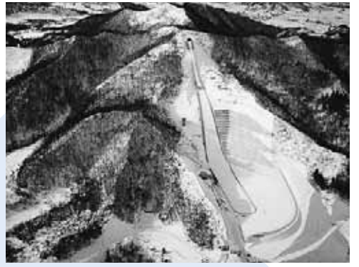
▲空からみた大倉山の全体（昭和47年撮影）
