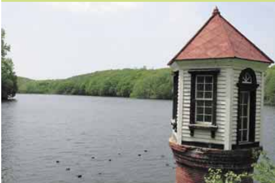
西岡水源池(右が取水塔)
