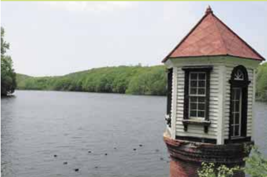
西岡水源池(右が取水塔)
