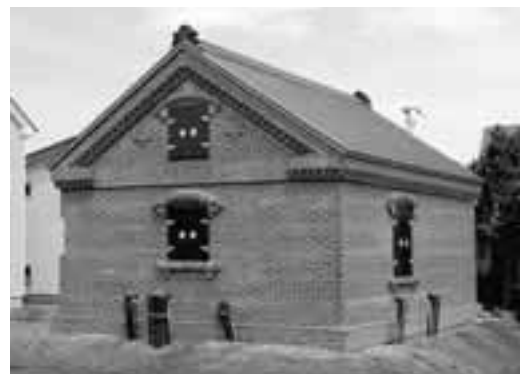
▲現在も豊平区内に残っているれんが造りのりんご倉庫
