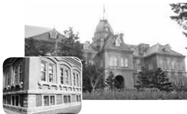
▲土台石や窓枠に硬石を使用した旧道庁本庁舎【(中)北3西6】
