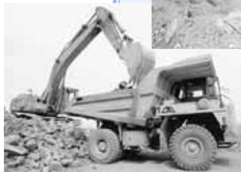
▲爆破した岩石をダンプカーで運びます
