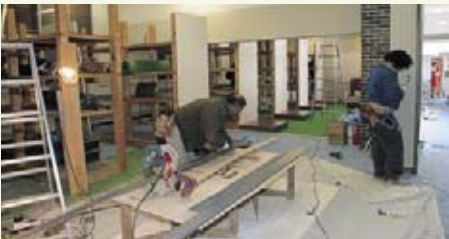
▶大掛かりな改修工事
