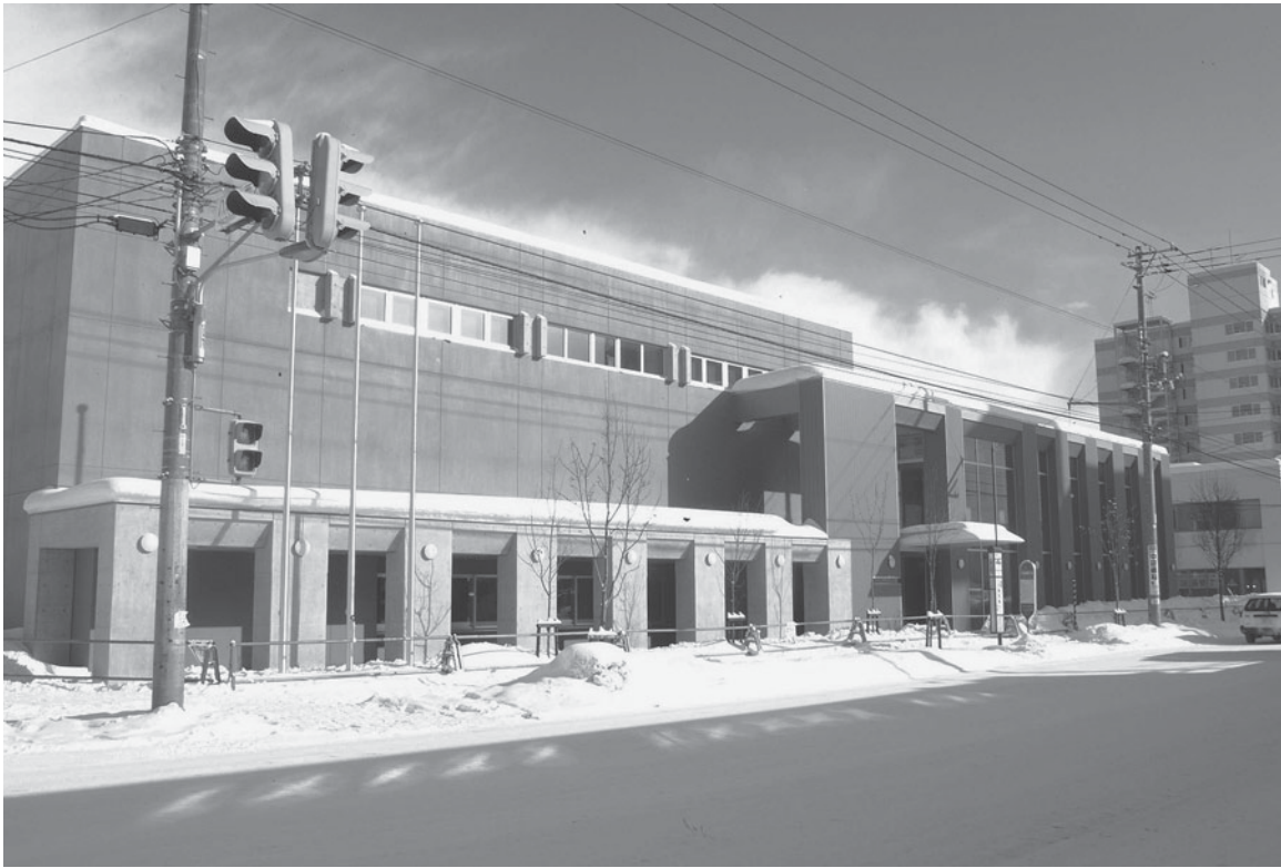
▲下手稲通側からの建物外観
