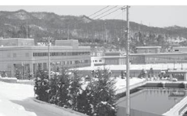
白川浄水場では、豊平川から取り入れた水（原水）の濁りを凝集・沈殿・ろ過し、塩素消毒を行い、おいしい水道水へと浄水処理をしています。同浄水場で一日に作ら
