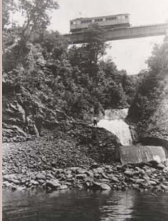
▲一の沢橋（一の沢駅～錦橋駅間） を渡る電車（昭和5年頃）
