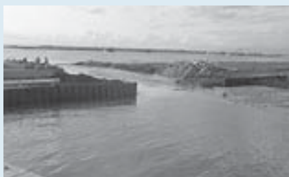
▲昭和56年8月、緊急通水したときの様子
