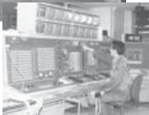
検査作業中の車両(上) 自動回送運転システム など車両運行を集中管理する信号扱所(右)
