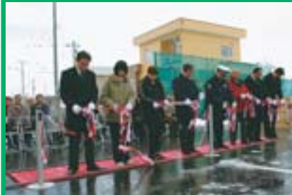
道央自動車道をまたぎ里塚地区と里 塚緑ヶ丘地区を結ぶ道路が完成。待 ちわびた道路の開通を祝い、式典が 行われました。
