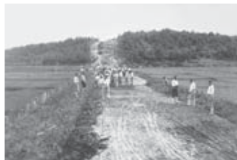
アンパン道路の工事（明治44年）
