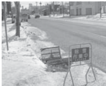
▲新琴似四番通の流雪溝。路肩に積もった雪は住民の協力で投雪口に消え、快適な通行が確保されている
