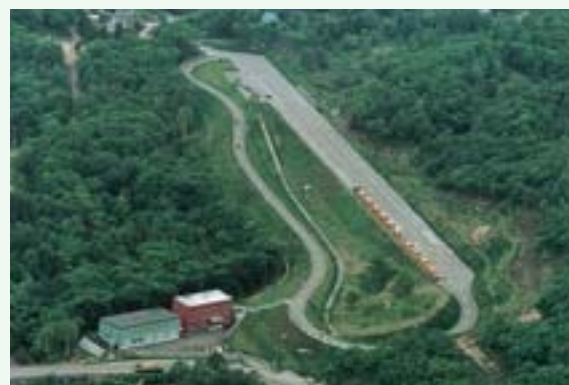
▲日本除雪機製作所が持つ、日本唯一の除雪専用テストコース（所在地：小樽市張碓町）
