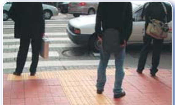
みんなが立ち止まる危険箇所を知らせる点字ブロック
