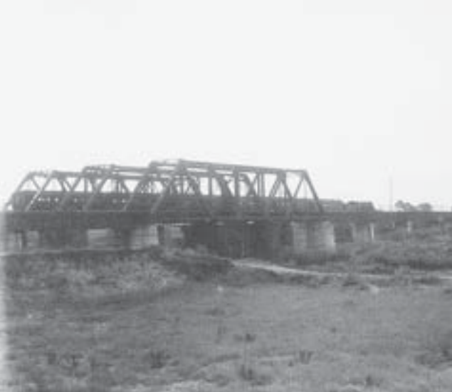
▶明治三十九年四月の北海道炭 礦鉄道の時刻表（手宮～岩見沢 間）。この半年後に国有鉄道と なる② ◀昭和五年ころの豊平川鉄橋。 三本の橋が架けられており、左 から函館本線（下り）、同（上 り）、北海道鉄道の順。写真奥 が白石村である③
