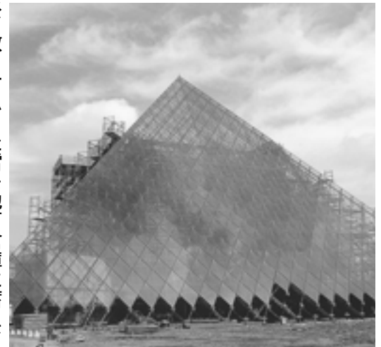
建設中のガラスのピラミッド。来年3月の完成に向け、急ピッチで工事が進められています
