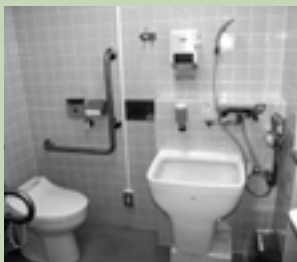
3月に豊平区役所に設置されたオストメイト対応トイレ
