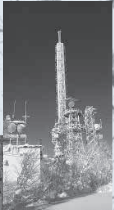
▶▶陽光を浴びる砂糖菓子のような木々と氷柱のようにそそり立つアンテナ群
