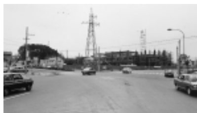
建設中の豊平区役所(昭和48年)
