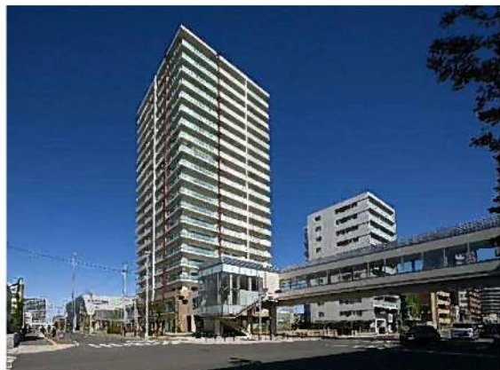
民間開発による空中歩廊の整備事例
