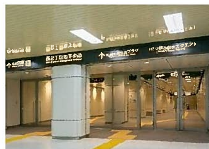
西2丁目地下歩道
